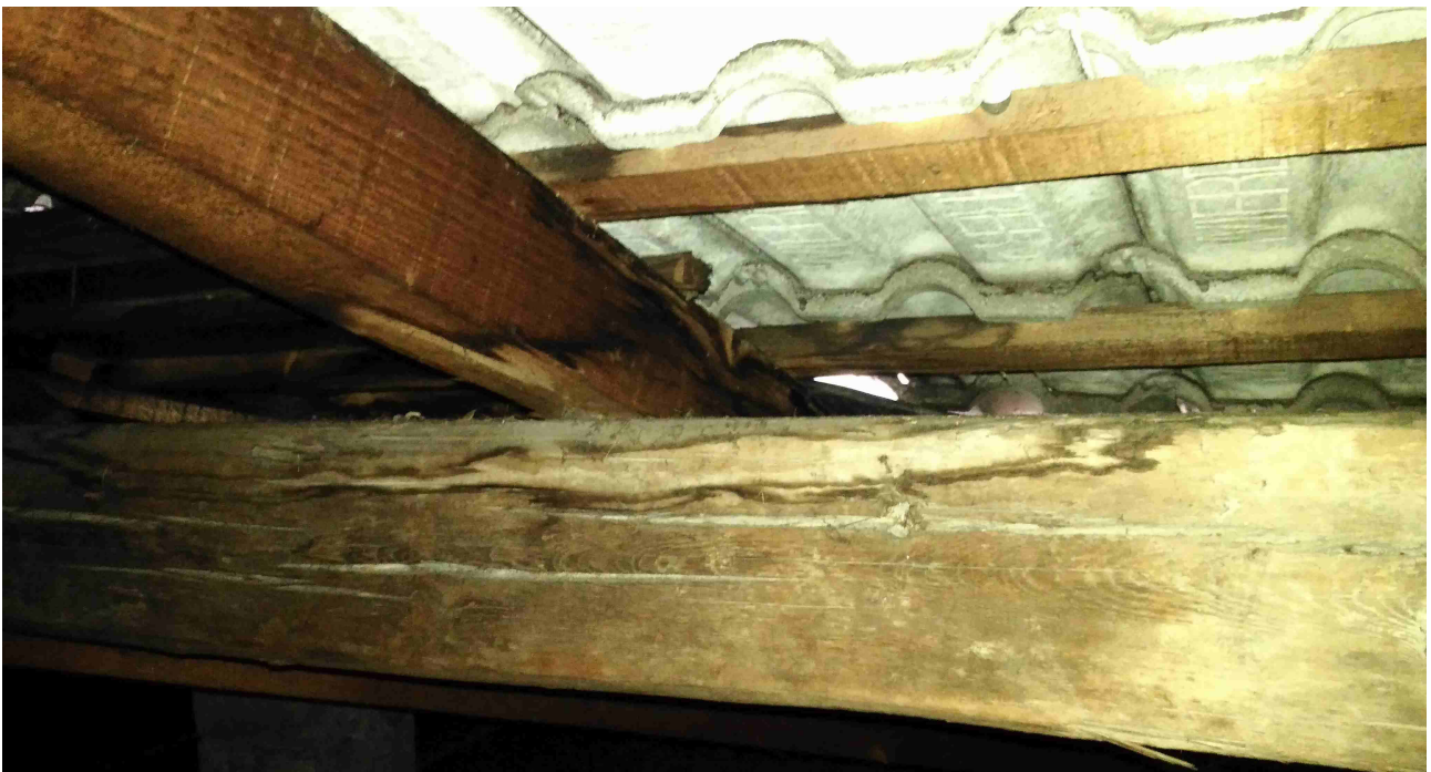
Stato di degrado di travi e orditura secondaria
