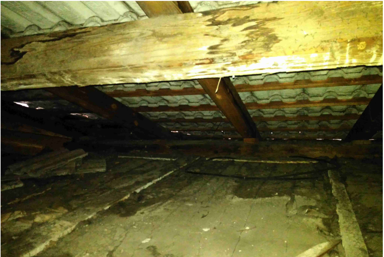
Stato di degrado di travi e pavimentazione
