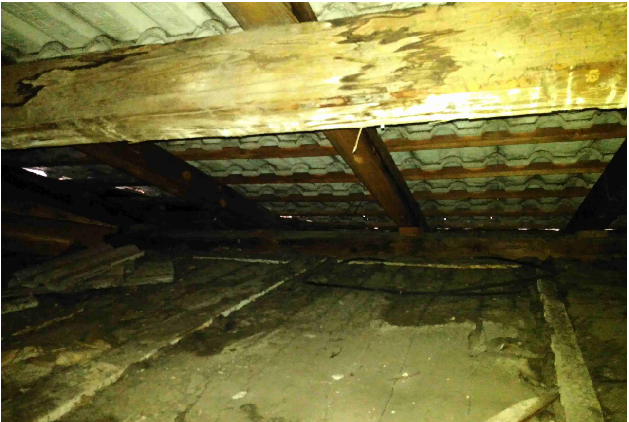
Stato di degrado di travi e pavimentazione
