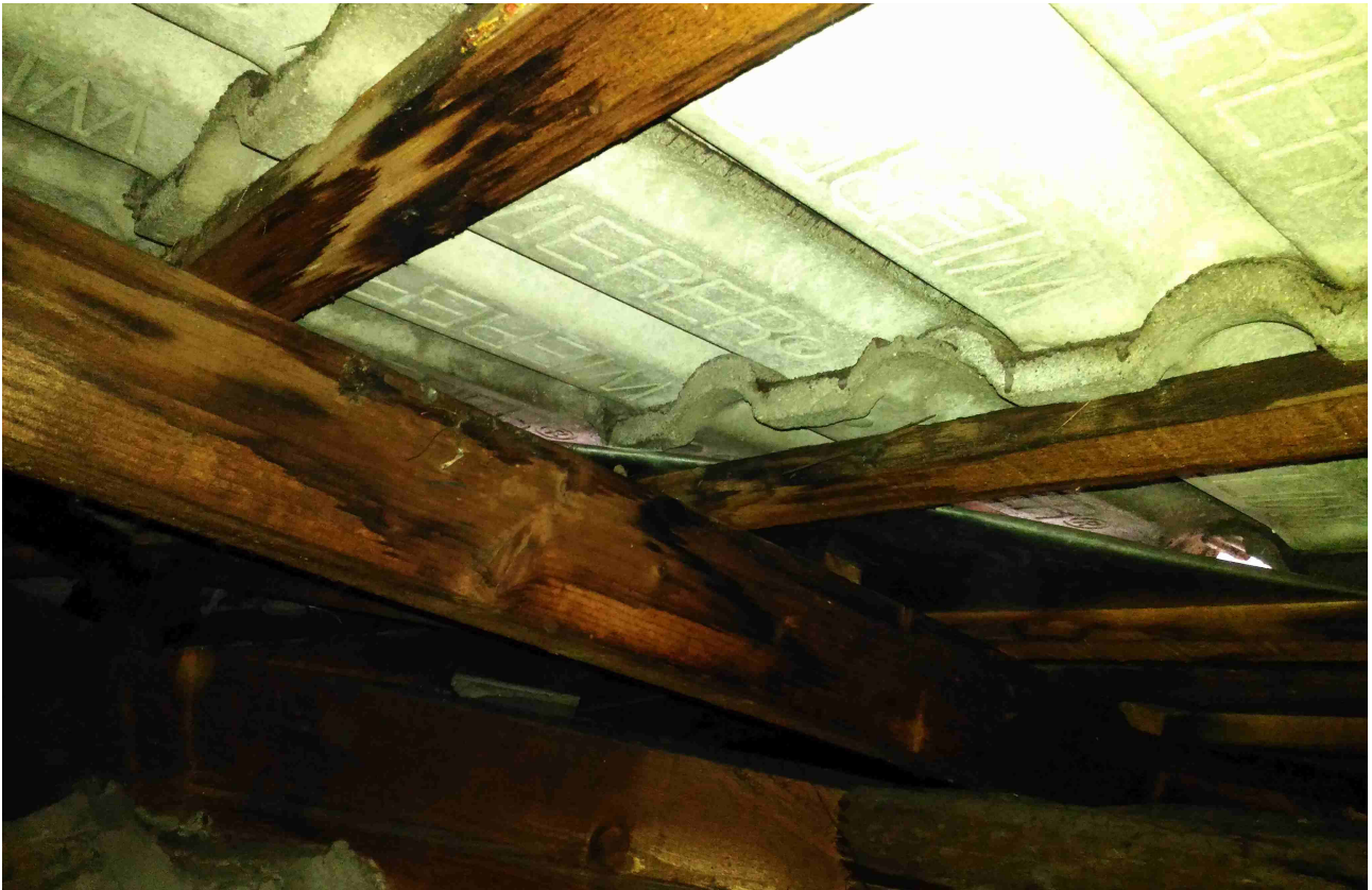
Stato di degrado di travi e orditura secondaria
