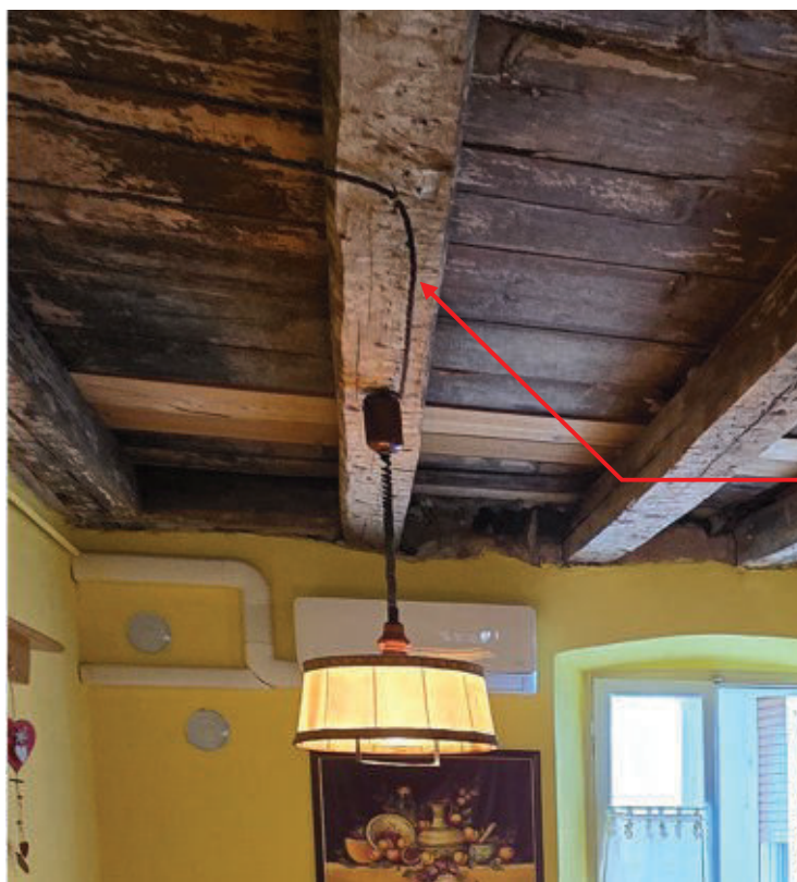
CAVO ALIMENTAZIONE PUNTO LUCE SOGGIORNO APPARTAMENTO TOSS
