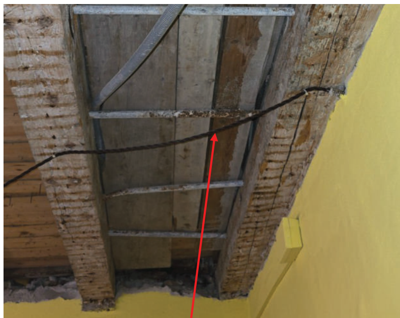
CAVO ALIMENTAZIONE PUNTO LUCE SOGGIORNO APPARTAMENTO TOSS
