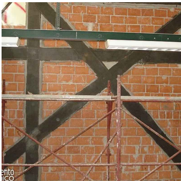
Fasce in fibra di carbonio ad alta resistenza - pramenti
