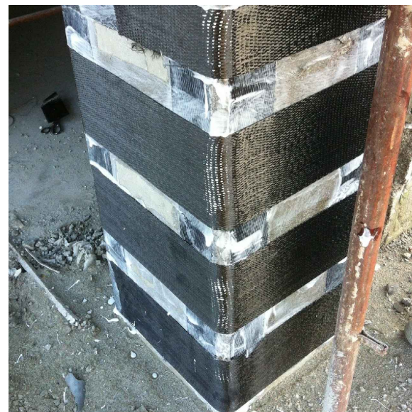
Fasce in fibra di carbonio ad alta resistenza - cerchiaggi
