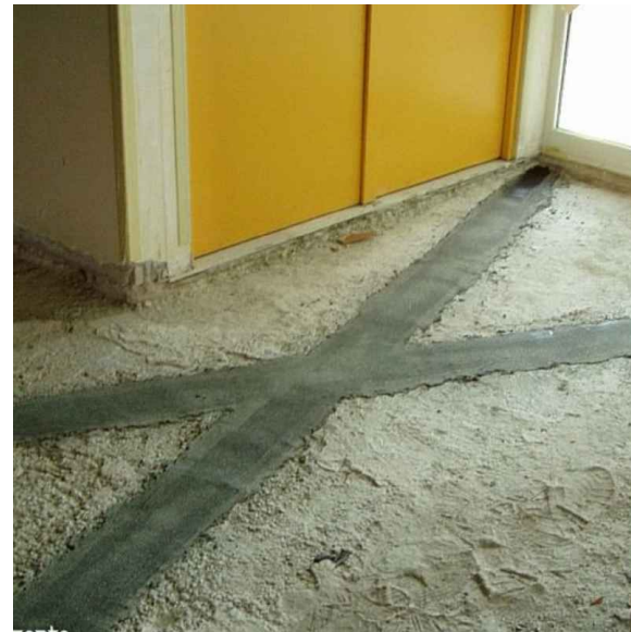
Fasce in fibra di carbonio ad alta resistenza - solai
