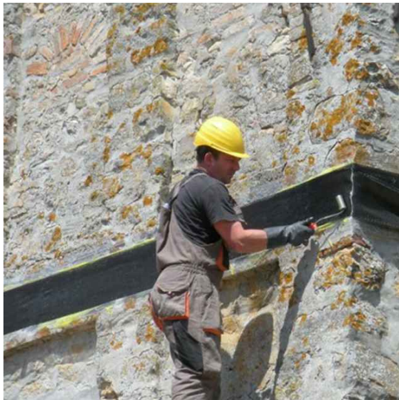
Fasce in fibra di carbonio ad alta resistenza - cordoli
